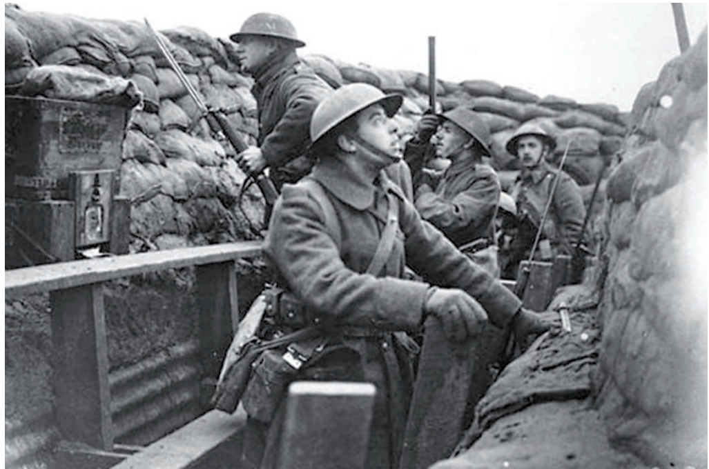
Photographie montrant des troupes britanniques utilisant un périscope de tranchée et un miroir de tranchée pour voir le no man's land.
